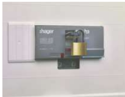
Wirksame Verhinderung des Wiedereinschaltens durch Laien (Sichtbarkeit der Kalibrierung sichergestellt)
